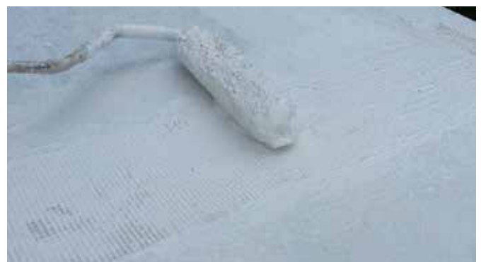
Eerste laag KÖSTER 21 met indien nodig KÖSTER Flexweefsel
