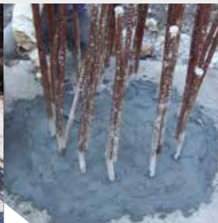
Een hoge plint maken en het oppervlak egaliseren met Köster Reparatiemortel WU
