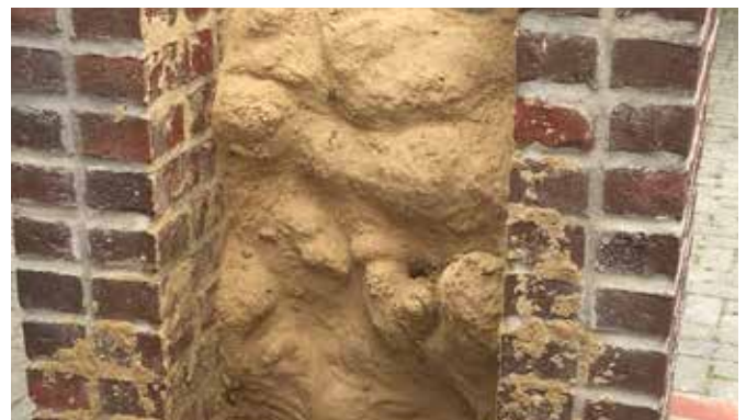
Zo ziet het er aan de buitenzijde uit.
