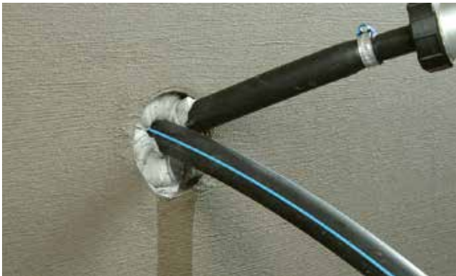
KÖSTER KB-Flex 200 wordt met het KÖSTER handpistool in de doorvoer gespoten.
