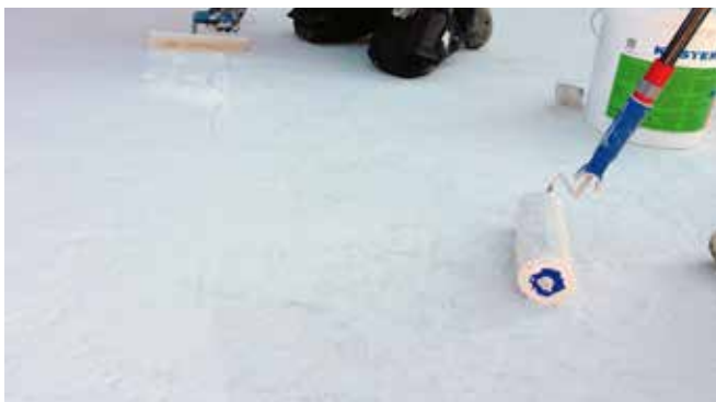
Opbrengen van de 2e laag KÖSTER 21
