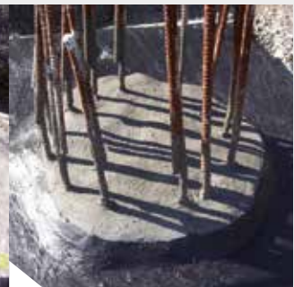
Aansluiting van de oppervlakteafdichting (KÖSTER Deuxan 2K) op de afdichting van de paalkop
