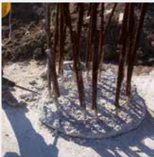
Verwijderen van uitpuilend beton en reinigen van het oppervlak
