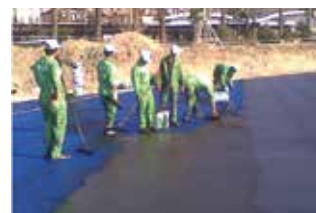
Afdichten met KÖSTER Deuxan 2K
