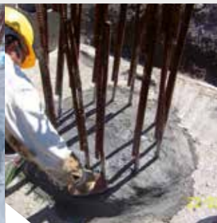
Afdichten van de paalkop met KÖSTER NB 1 grijs
