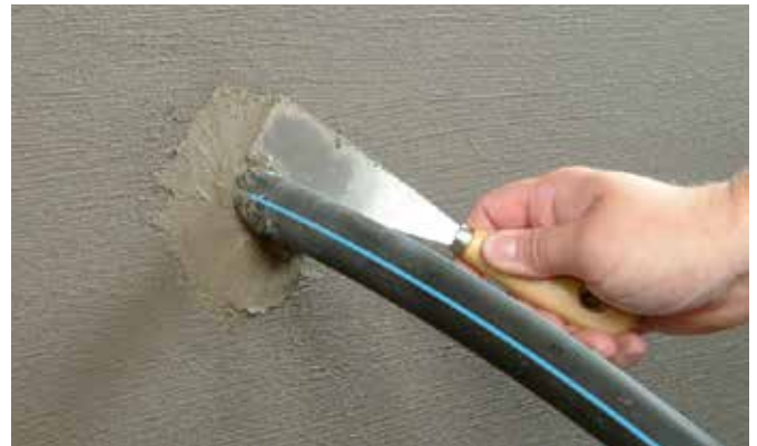
Als druklaag afwerking is het oppervlak met KÖSTER KB-Fix 5 afgespateld.
