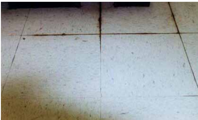
Vocht en een hoge pH-waarde lossen lijmen op...
