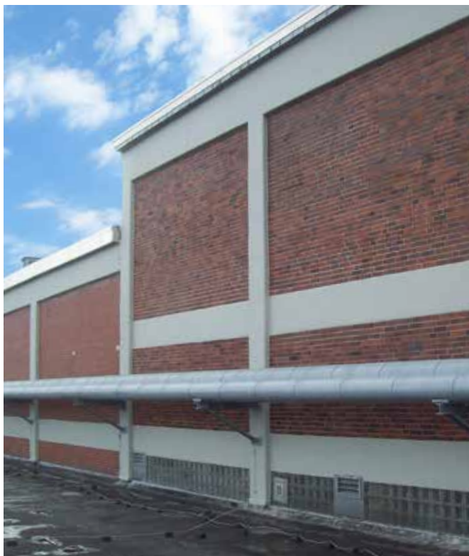
Melitta in Minden, Duitsland: na betonreparatie en gevelbescherming
