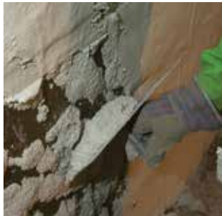
Opbrengen van KÖSTER Saneermortel 2e laag
