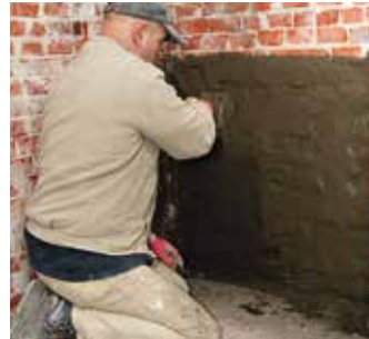
4 KÖSTER Kelderdicht 1 Pasta: 2 lagen (tweede laag na 30 minuten)
