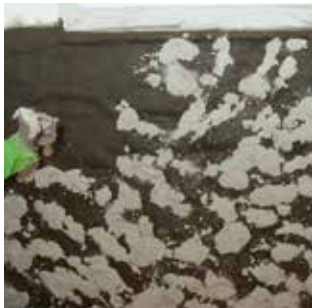
Aanbrengen van een spritzlaag KÖSTER Saneermortel
