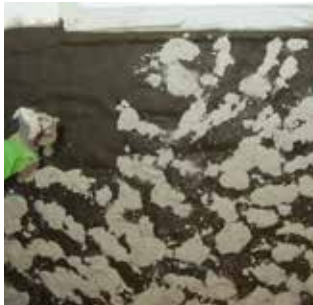
1e laag KÖSTER Saneermortel Spritslaag
