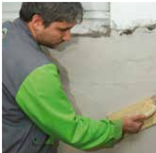
Afwerken van de stuclaag
