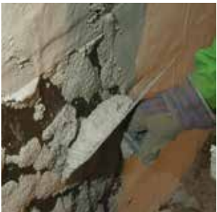
2e laag Saneermortel
